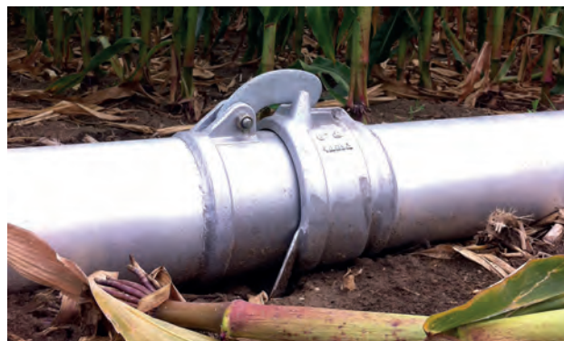
Installation en 6" sur maïs
