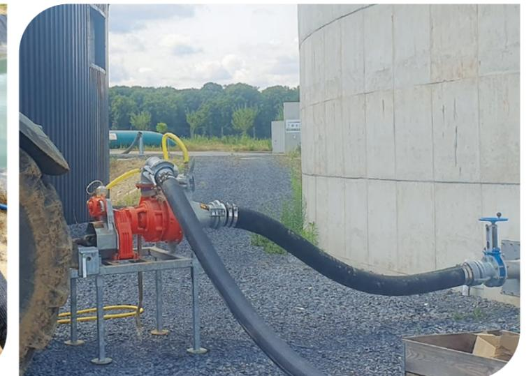
Pompe HD Doda derrière prise de force tracteur - Transfert de digestat
