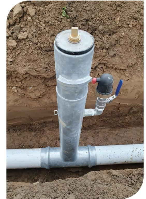
Colonne de remontée à emboîtement VBZ 5" avec purge d'air
